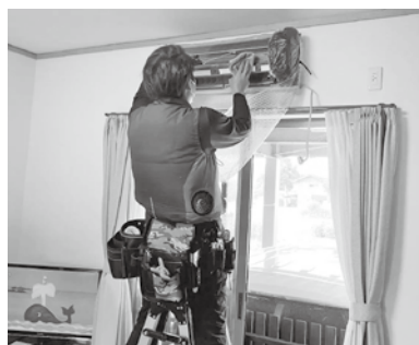
エアコンの洗浄作業
