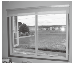
こだわりの詰まった 来客スペースの壁と窓枠
